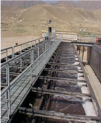
ناشرات الهواء بحوض التهوية
