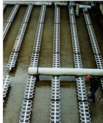
ناشرات الهواء بحوض التهوية
